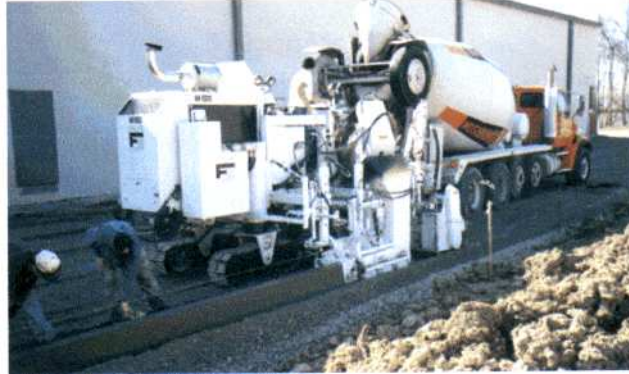
Machine à coffrage glissant
